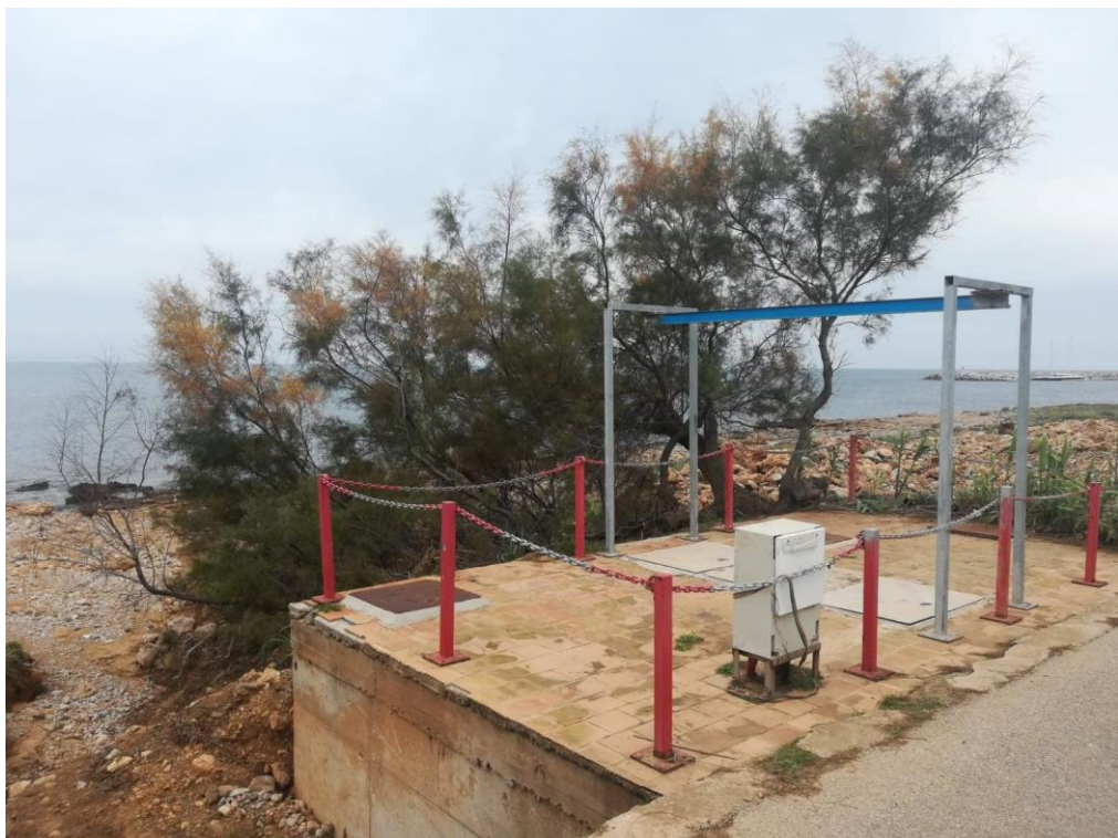
Fotografia 8. Ubicació actual de l'EBAR Intermitja
