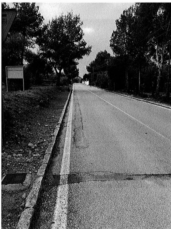
Il·lustració 10. Rasa on es situa l' inici tub impulsió PE a San Pedro-Betlem.
