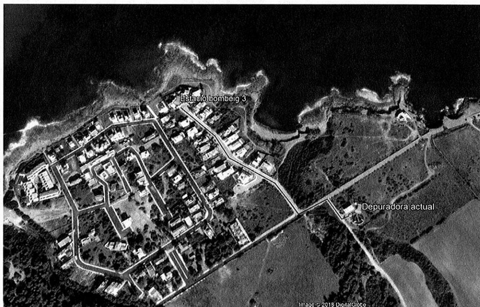
Il·lustració 7. Canonada impulsió S' Estanyol-Depuradora
