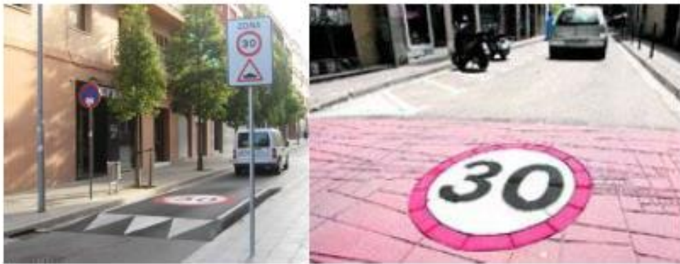
Fig. 56. Portes d'entrada a zona 30
