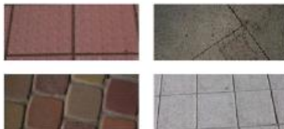
Fig. 41. Tipologia de paviments
